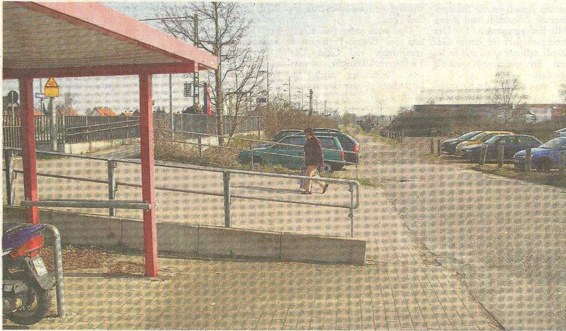
Der Fußweg an der Südseite soll nach Wunsch des Bauausschusses beleuchtet werden.
